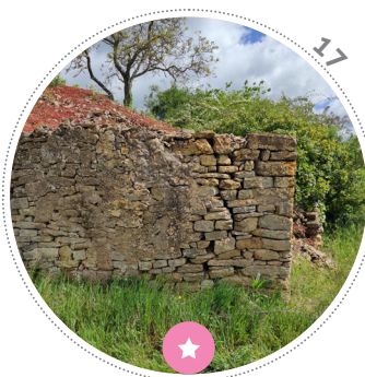
17 Cette maçonnerie est un vestige d'une cadole aujourd'hui quasiment disparue. Le propriétaire a attesté avoir connu cette cadole, signe de la fragilité de ces ouvrages.
