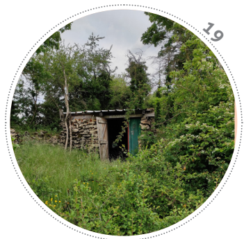
19 Cette cadole a été largement modifiée avec des matériaux récents pour préserver son usage.
