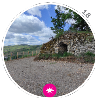
18 Cette cadole engagée présente un intérêt majeur par la présence d'une charpente de bois équarris.
