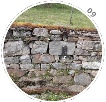
Parement d'un soutènement de jardin le long de la voirie. On relève des assises régulières en partie basse et l'intégration de pierres de grandes dimensions dans le corps de maçonnerie.
