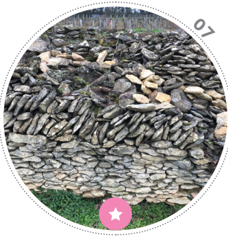
Parement présentant deux assises de pierres posées en Opus piscatum . La partie haute du murger est effondrée ou n'a peut-être jamais été achevée. Ce parement est en continuité d'une cadole engagée dans le murger qui maintient les terres du chemin.
