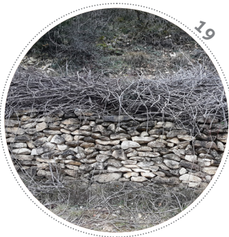
Exemple d'un détail de la vie des ouvrages avec l'exploitation viticole. Les tailles hivernales sont regroupées en couverture du murger de lisière.
