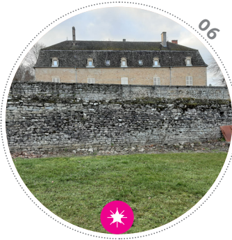
06 Parement en Opus Quadratum du mur de soutènement de la voie qui passe entre l'enceinte du château et le parvis bas également clos de murs de pierre sèche.
