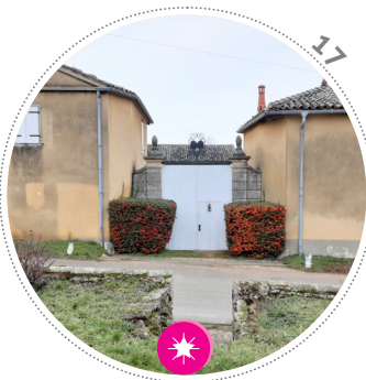
17 Un escalier permet d'accéder aux parcelles de vignes Les Chailloux. Il est axé sur la porte de la maison forte.
