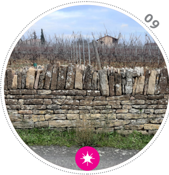
09 Parement en Opus Quadratum d'un mur de soutènement sans doute restauré. Il présente une belle couverture de pierres posées sur chant.
