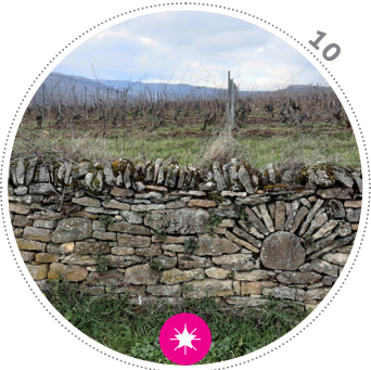
Mur ayant fait l'objet d'une restauration. Il présente un parement rayonnant autour d'une pierre circulaire à la manière d'un arc clavé.
