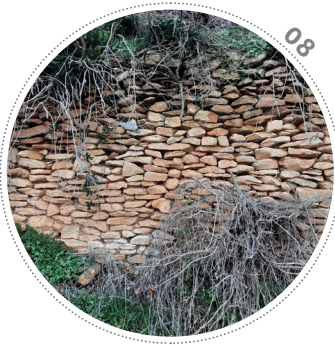
Ce murger de lisière maintient les terres de la zone boisée entre le haut et le bas du secteur Côte Rôtie. La couleur des pierres du parement et leur aspect «délavé» semblent indiquer que le maillage est soumis à un fort ruissellement.
