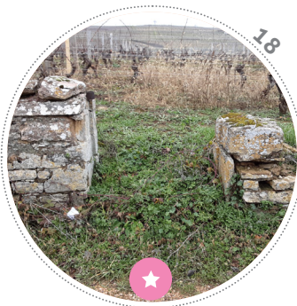
18 Le long de la rue du Paradis, on trouve un fin muret de pierre dans lequel sont ménagées deux ouvertures sur le secteur Le Clos qui répondent au parcellaire actuel. Un gond est encore visible et les pierres sont soigneusement taillées en feuillure.
