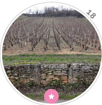
Ancien passage vers les vignes obturé. On voit encore les deux stèles qui formaient les jambages de l'ouverture.
