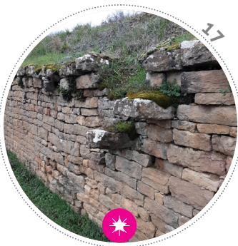
Restes d'un escalier permettant d'accéder depuis la route aux parcelles de vignes. Les marches posées en boutisse émergent du parement.
