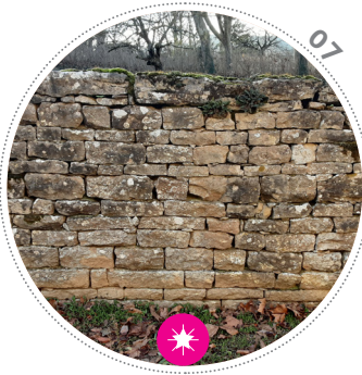
07 Parement en Opus Quadratum du mur de clôture du bois du château de Chevignes.
