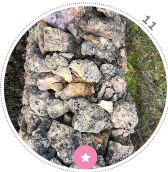
Muret de vignes formé de petites pierres se dégradant en feuille ou écaille.
