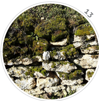
Pierres d'un mur de soutènement d'une voie.
