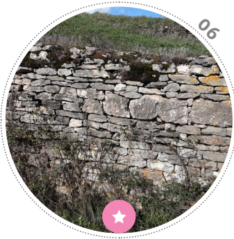
Ce mur de soutènement présente un parement élégant d'assises régulières en Opus quadratum .
