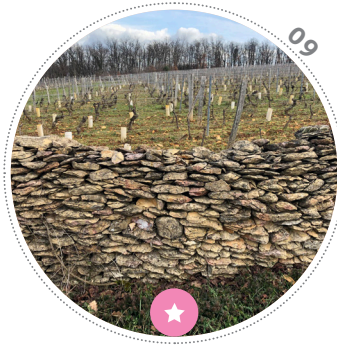
Muret marquant la limite entre les parcelles AOC du château des Rontets. L'enceinte est continue, malgré la dégradation avancée, tout le long du domaine. La qualité des pierres qui se décomposent en écailles, sols issus de calcaires à Chailles, explique la déchéance de l'ouvrage.
