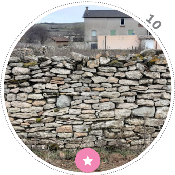
Portion d'un linéaire de clos en pierre sèche. La mise en œuvre est modeste mais l'ouvrage est robuste.
