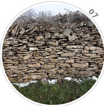
07 Parement d'un mur de soutènement du secteur Les Crays. La mise en œuvre est plus irrégulière et les assises de pierre sont plus fines malgré la proximité du mur précédent.
