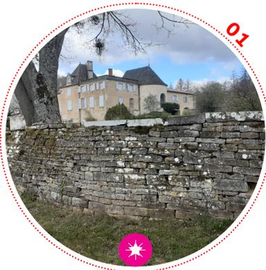
Face au château se déploie un jardin classique de parterres plantés. La terrasse est maintenue par de hauts murs de soutènement à joint sec en gradin.
