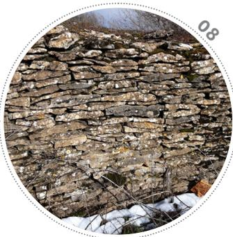
08 En continuité du dernier soutènement, le parement ordonné du murger en cœur de vigne ne laisse pas transparaître le changement de type d'ouvrage.
