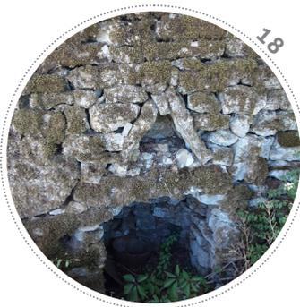
Ces niches se trouvent en partie basse d'un soutènement marquant l'entrée dans le secteur Les Longues Raies. Sa morphologie est singulière pour une construction en pierre sèche. La niche basse est surmontée d'un linteau avec un triangle de décharge.
