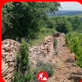
Ce linéaire est à reprendre en priorité car il présente de larges brèches qui mettent en péril la stabilité de l'ensemble de l'ouvrage. La fréquentation est intense sur ce chemin et le passage étroit pour les engins. Il faut prendre en compte ce sujet dans le projet de restauration et protection. (chasse-roue, butée...)
