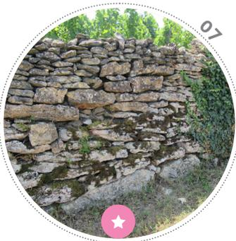
Ce parement d'un mur séparatif montre l'importance du tri des pierres dans le montage de la maçonnerie. En partie basse, on trouve de grandes pierres longues tandis qu'au sommet les moellons sont de taille modeste.
