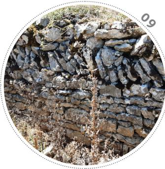
Ce mur de soutènement se trouve dans le secteur Les Longues Raies. Il présente un détail typique de couverture des ouvrages de vignes talutés.
