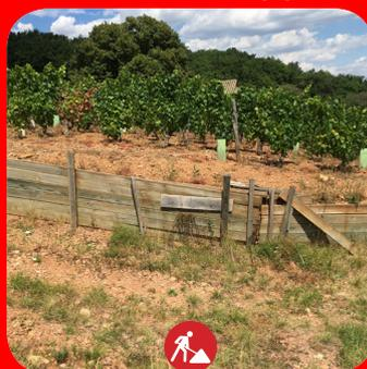
Comme noté sur le diagnostic sanitaire, plusieurs ouvrages de soutènement sont éliminés et remplacés par des berlinoises. La démolition doit faire l'objet d'un permis ! Il faut aussi établir d'urgence une règle de conduite pour gérer les ruines d'un ouvrage : tri et stockage des pierres pour réemploi local par exemple.
