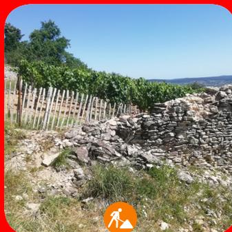
La jonction haute du mur d'avec le murger de lisière est effondrée. La partie basse est en araché puisque la tête de mur a perdu son chaînage d'angle. Rebâtir ces éléments permettra d'assurer sa stabilité en stoppant les dégradations.
