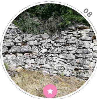
Ce parement présente une pose en *Opus incertum*. Les moellons sont de tailles diverses et sont répartis plus ou moins uniformément dans la maçonnerie. Pourtant ces pierres offrent des moellons d'une taille et d'une morphologie notable témoignant de la présence d'un affleurement rocheux particulier dans le secteur.
