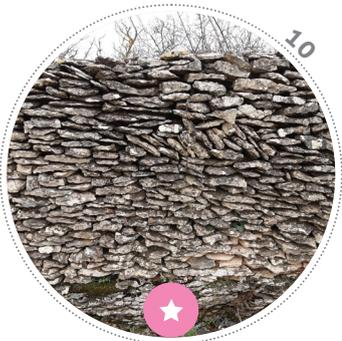
Parement d'un murger de lisière fondé sur un affleurement rocheux. On peut directement percevoir la corrélation des pierres employées pour la confection de la maçonnerie et la roche similaire en pied.
