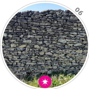
Ce parement d'un mur séparatif, témoigne d'une grande connaissance technique. On retrouve des chaînes de pierres horizontales à épaisseur plus importante qui permettent de rigidifier la structure de la maille tous les 4 à 5 lits.
