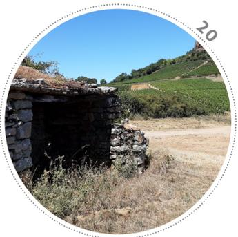
Cette cadole est bâtie en bout d'un murger. Elle marque l'entrée du secteur Les Longues Raies. Sa forme parallélépipédique est singulière. Elle est formée d'une maçonnerie en coude en appui sur le murger. Sa couverture est assurée par de fins chevrons de bois qui ne supporteront plus longtemps le poids des dalles en couverture.
