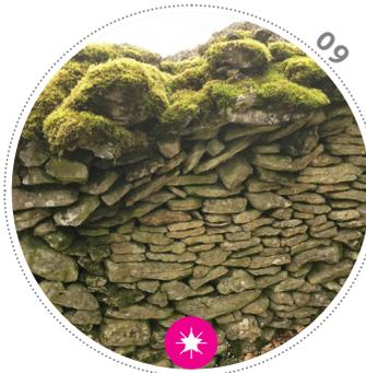
Pour ce mur, le parement est composé de pierres assez plates et d'épaisseur plus importante à la base de la maçonnerie. La singularité réside dans le système de couverture en saillie du parement. Ces dalles protègent le mur de la grande humidité du secteur.
