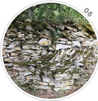
Ce mur de soutènement présente un détail intéressant perceptible sur son parement. Les pierres sont disposées en *Opus piscatum* séparé par deux lits réguliers. Il permet sans doute de répondre à une nécessité de drainage des terres entre la route au dessus et le chemin en contre-bas de l'ouvrage.
