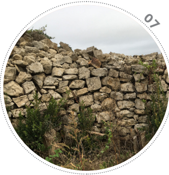
07 Parement en Opus incertum d'un murger de cœur de vigne du secteur En Carementrant. Le type de pierre employé provoque une esthétique de parement très différente. La parcelle ainsi délimitée par cet ouvrage est déjà visible au XVIII e siècle. Il pourrait s'agir d'un ouvrage originel.
