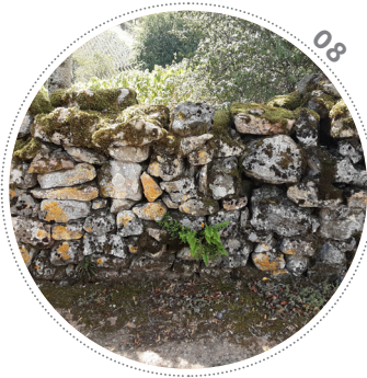
Parement de gros moellons arrondis en opus incertum d'un mur situé le long du chemin conduisant à la Denante, non loin du lieu-dit la Folle.
