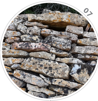
Mur de lisière au lieu-dit la Carrière présentant un double parement de moellons relativement fins.
