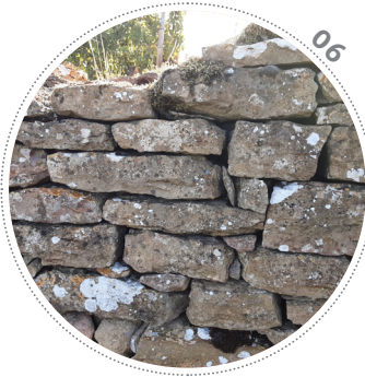
Parement de larges moellons taillés et posés en assises régulières, avec pierres de calage, sur un mur de soutènement aux Vignes de la l'eau.
