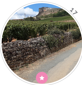
Ce long mur de soutènement menant au Moulin présente un couronnement particulièrement soigné, de forme semi-arrondie.
