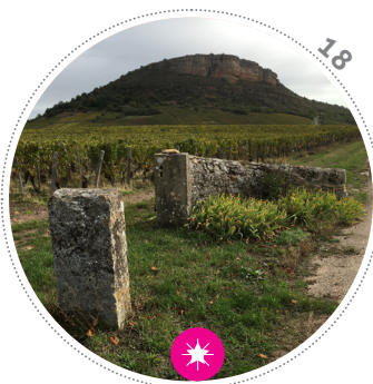
18 Stèles taillées présentant des encoches et paumelles pour une barrière. Un mur maçonné au mortier et un parterre d'iris prolongent le portail.
