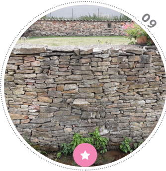
Parement régulier de moellons taillés du mur de soutènement et d'enceinte du jardin du Moulin. Le couronnement du mur est formé de larges pierres plates posées à plat sur l'ouvrage.
