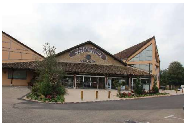
Caveau de la cave coopérative de Prissé
